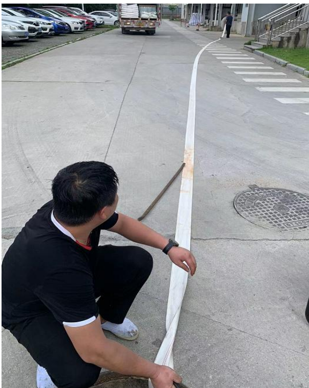
铺设抽水管道至应急抽水管
