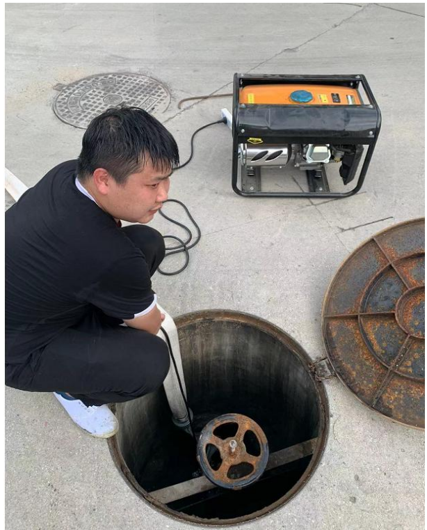
抽空雨水管道的水,并用自来水冲至 pH 呈中性
