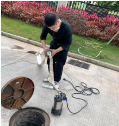
水泵放入雨水口，并接通管道
